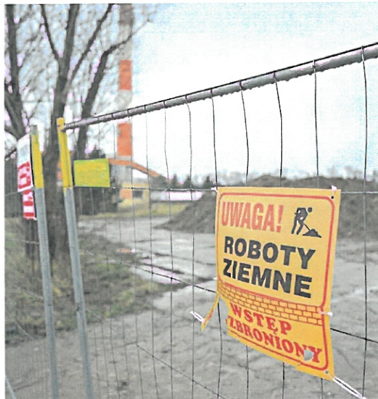
Szacowany koszt budowy tarnowskiej spalarni to 250 mln zł. MPEC otrzymał 175 mln zł preferencyjnej pożyczki i ponad 70 mln zł dotacji z NFOS Fot. Paweł Topolski
